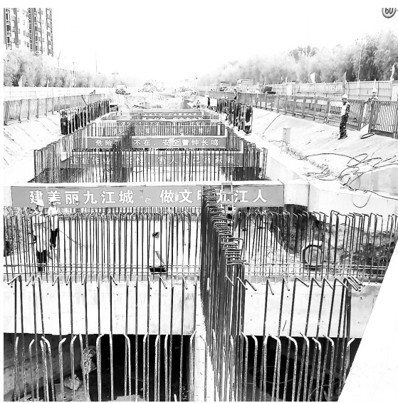
城市地下综合管廊项目快速推进
