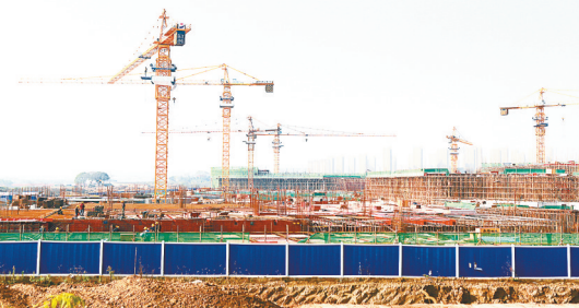
鄱阳湖生态科技城项目建设热火朝天
