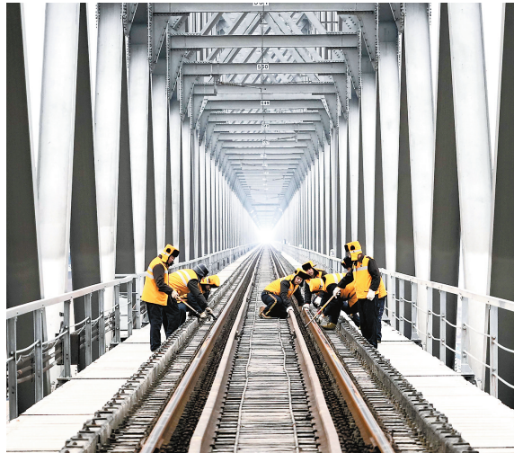
2月18日，中国铁路郑州局集团有限公司新乡桥工段东明桥梁车间职工检查大桥线路设备状况。
