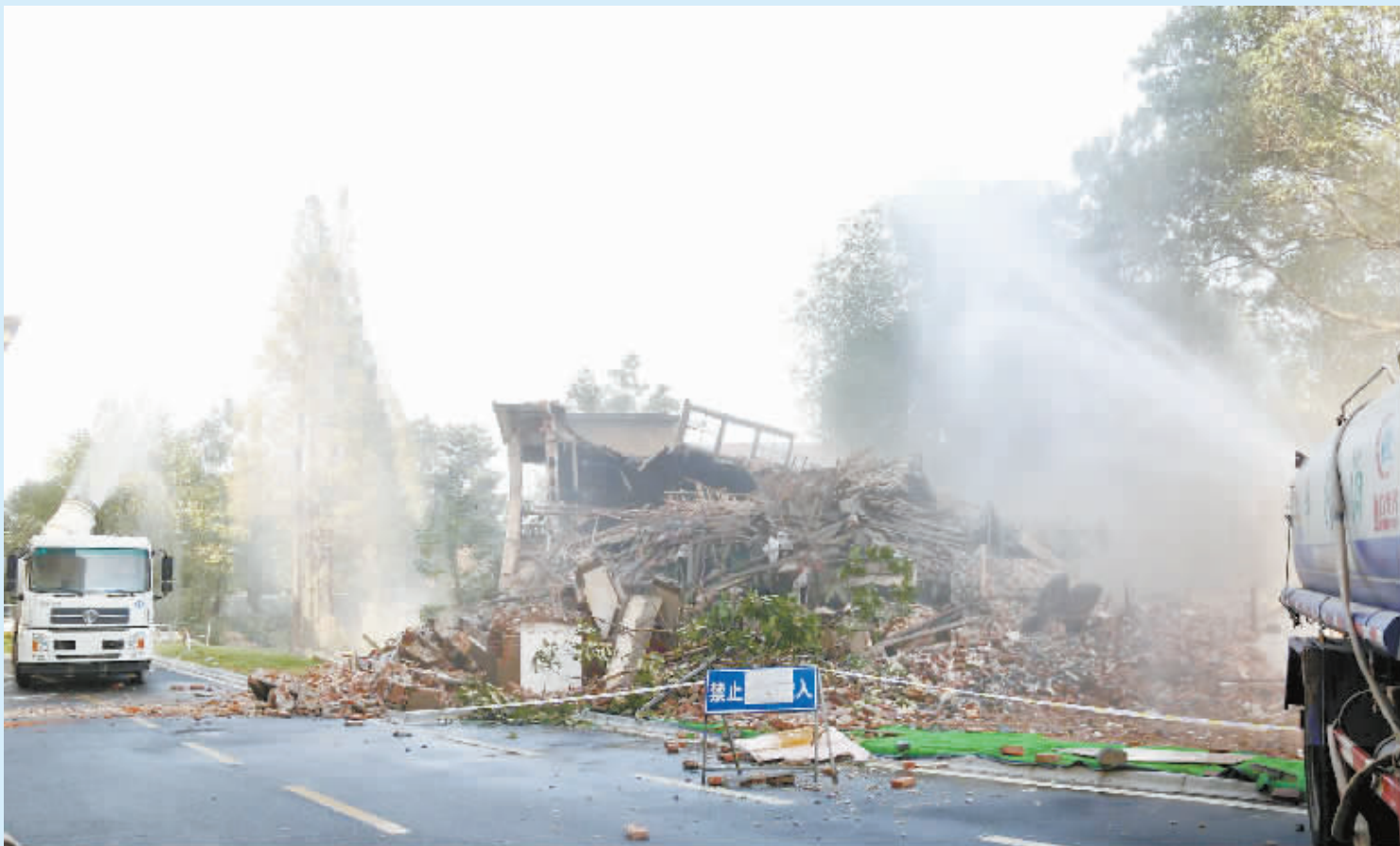
10月29日,八里湖新区组织房管、执法、国土、市容、街道办等多个部门单位人员对畔湖社区的部分违章建筑进行了强制拆除 (李若愚 摄)
