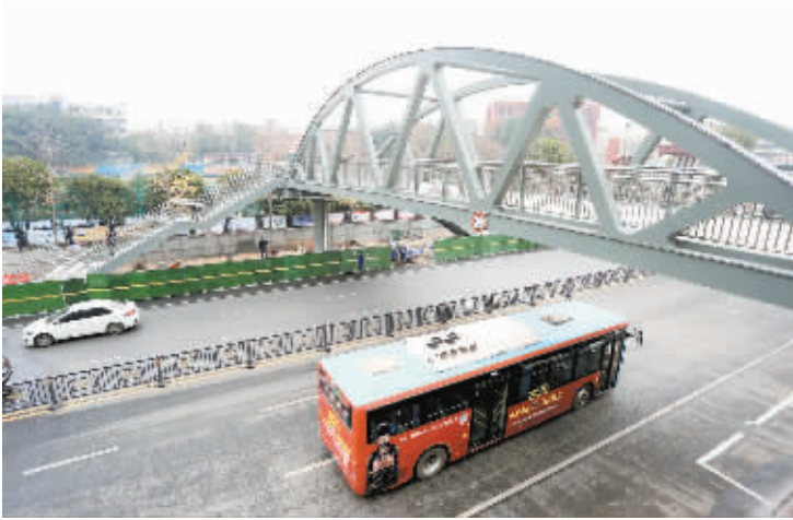
12月17日,九江一中人行天桥项目已进入最后的收尾阶段,天桥主体施工全部完成,正在进行桥身的擦拭清理,天桥下方紧邻学校一侧的人行道尚有部分地砖仍在铺设,这几天也将全部完工。待验收合格后,天桥很快将投入使用。(本报记者 刘家 摄)
