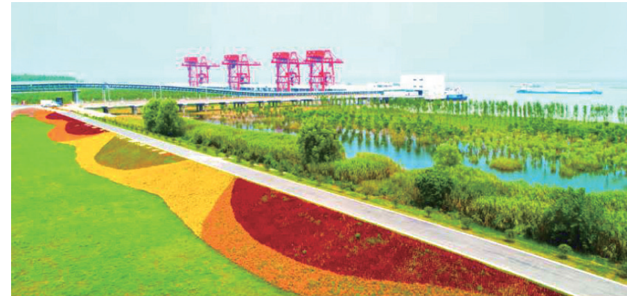
神华码头段(堤内)
