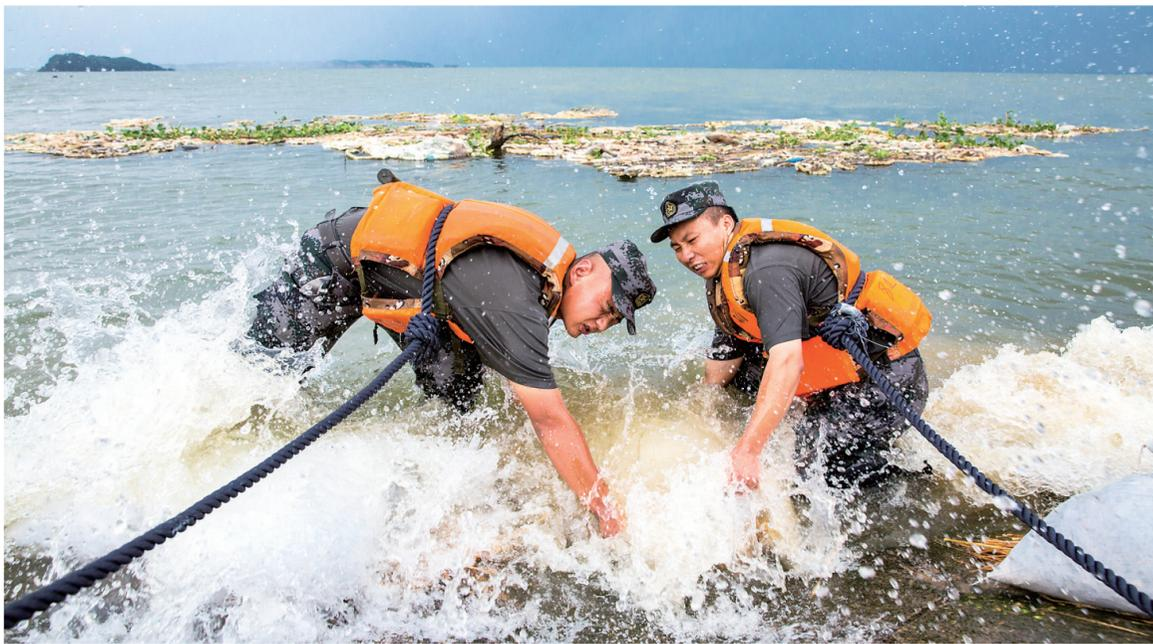
7月19日,在鄱阳湖矾山联圩中坝,东部战区陆军第71集团军官兵在水中抢险。自7月上旬以来,鄱阳湖持续超警戒水位,沿湖堤坝长时间受洪水浸泡,防汛形势严峻。近日,鄱阳湖区风力加大,都昌县矾山联圩外堤受风浪冲刷,险情不断。接到险情后,东部战区陆军第71集团军官兵迅速投入抢险,进行防风浪处理,保障大堤安全。
