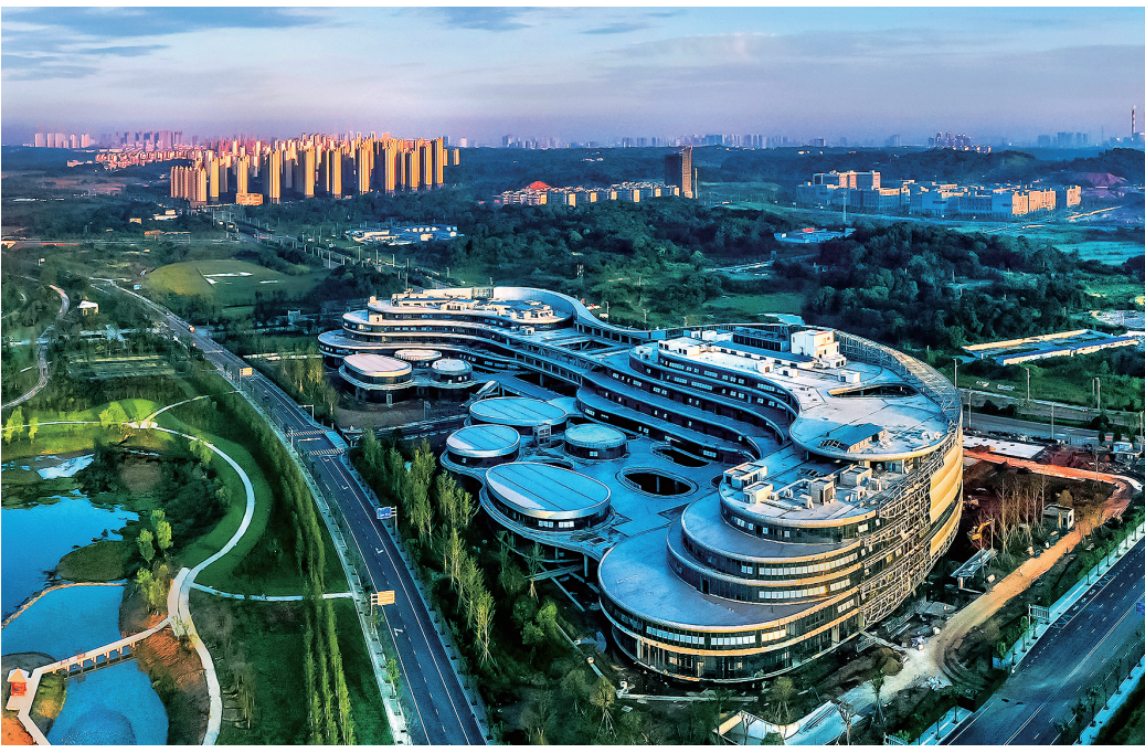
“十四五”全省重点工程“智慧九江”城市大脑项目,坐落于鄱阳湖生态科技城。
