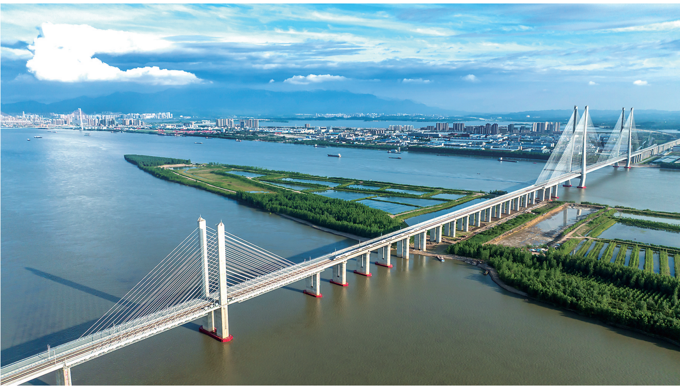
安九铁路鳊鱼洲长江大桥是京九客专跨长江的重要工程。
