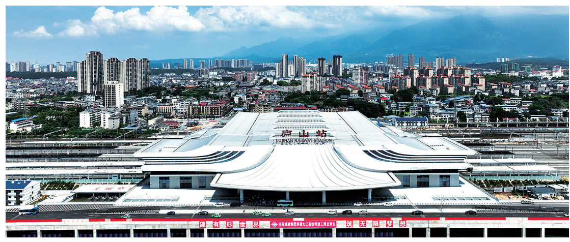
九江首座高铁站——庐山站扩改建完成后,将成为江西第二大高铁站,全国第二个“上进上出”式高铁站。
