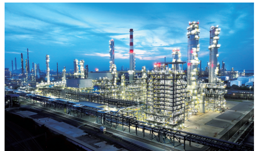
中国石化第三代芳烃技术首套工业应用装置——九江石化89万吨/年芳烃联合装置一次开车成功。
