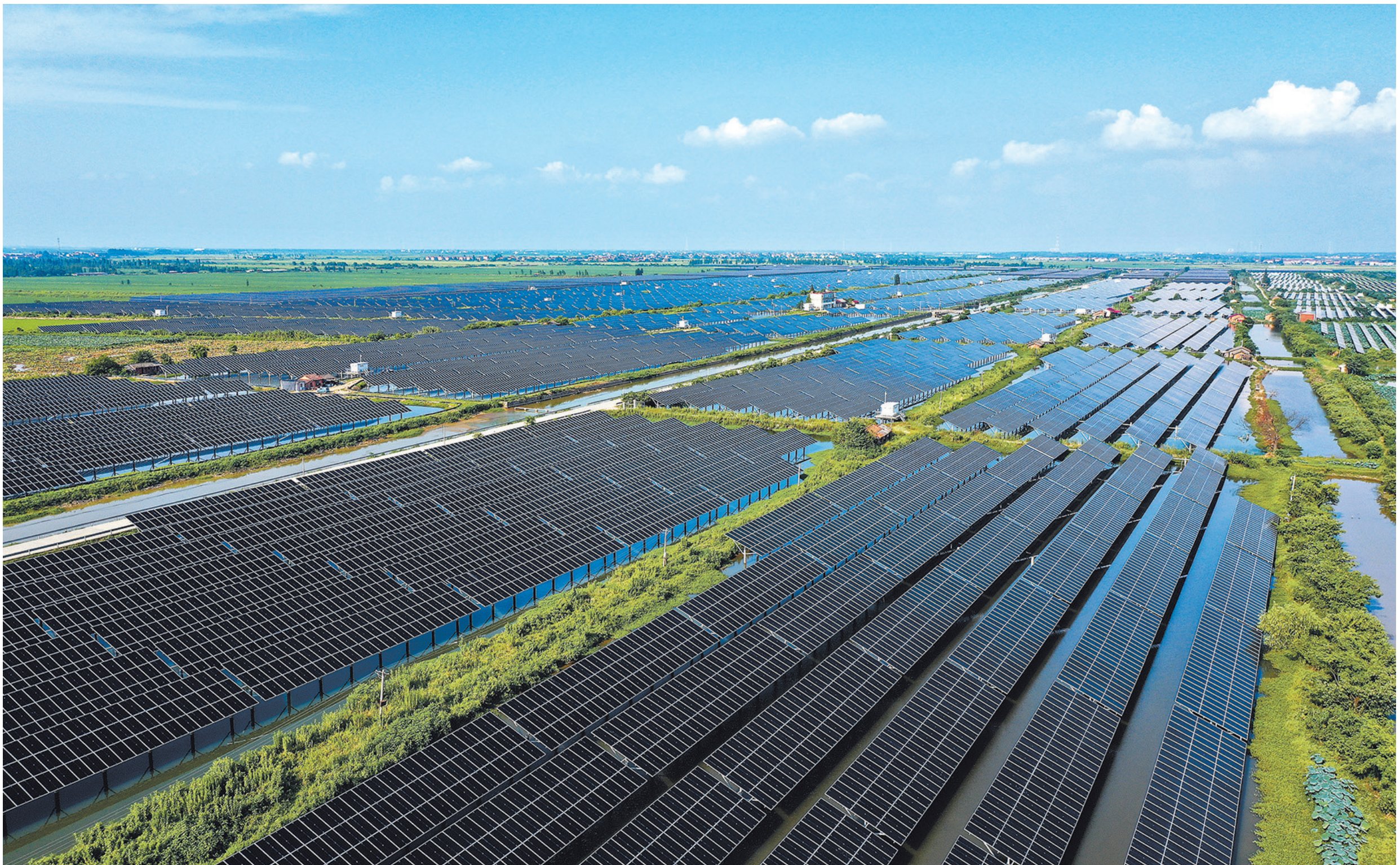
在南昌县蒋巷镇三洞湖,一排排光伏面板矗立湖面,正源源不断输出清洁电能。该项目将水产养殖与光伏发电相结合,形成“板上发电、板下养殖”新模式,提高了土地使用效率,助力乡村振兴。
