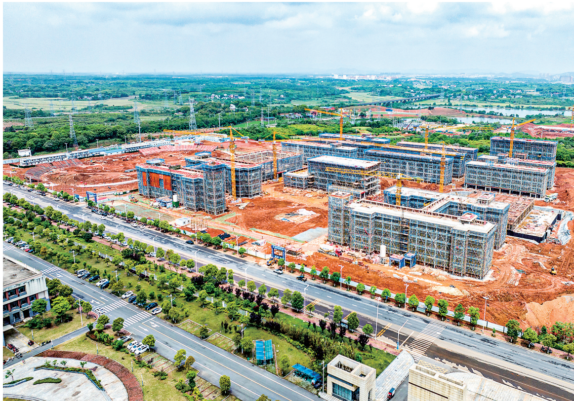
近日,赣江新区(共青)中职教育基地迎来主体封顶,标志着该项目建设取得阶段性进展。截至目前,共有10栋主体结构实现封顶。该项目总用地面积超13万平方米,总建筑面积超8万平方米,主要建设内容包括教学楼、食堂报告厅、实验科技楼、艺体楼、宿舍、运动场环跑跑道等,项目建成后将进一步改善共青城市教育教学条件、补齐共青城科技城基础设施短板,对教育事业高质量发展具有重要意义。(李文琪 本报记者 刘家摄)
