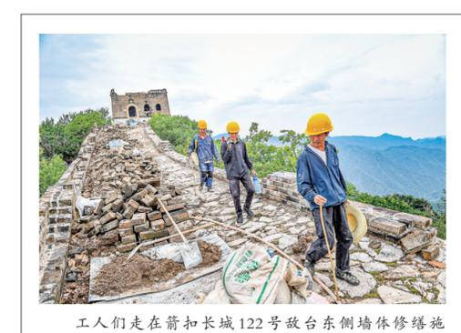
工人们走在箭扣长城122号敌台东侧墙体修缮施工现场(7月2日摄)。
