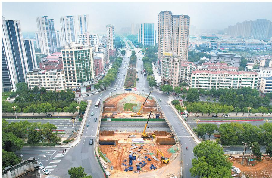
本报讯(记者周慧超/文 洪显智/摄)9月22日清晨,九江长虹立交桥拓宽改造施工现场一片忙碌:蓝色围挡内,几台钻机轰鸣作业,钻杆不时深入地下,一旁已完成施工的16根钻孔灌注桩整齐排列,施工人员正忙着对桩体质量进行复检,喷淋降尘系统不断喷出细密水雾,空气中交织着机械运转声与淡淡的水泥味,展现出项目稳步推进的热火态势。
