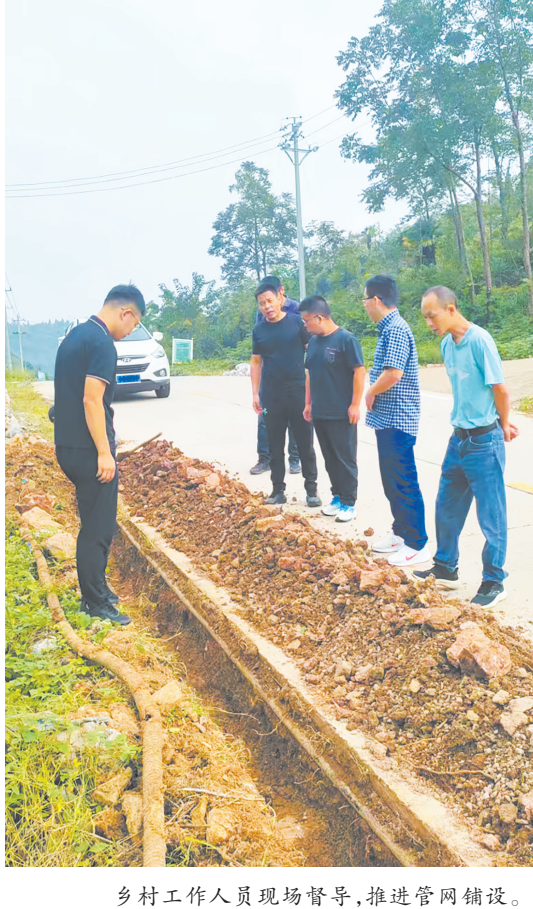
乡村工作人员现场督导,推进管网铺设。
