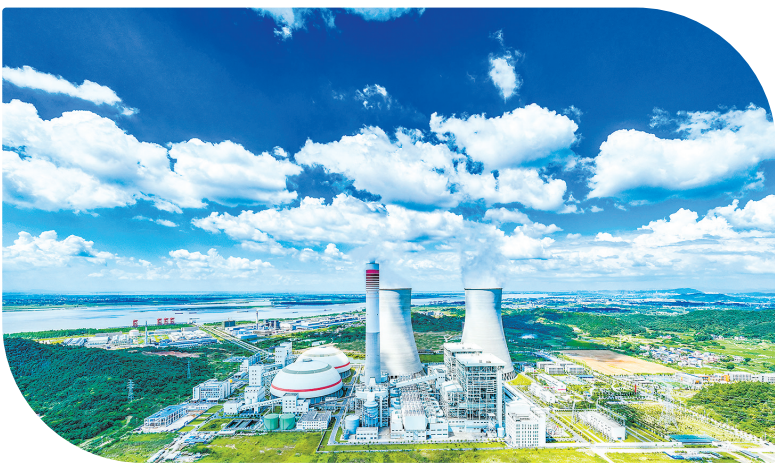
湖口高新技术产业园区的国能神华九江电厂1号机组成功投运中国首台百万机组数字化与智能稳燃系统。
